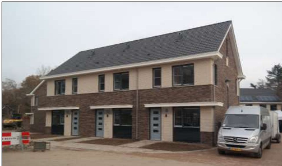
Nieuwbouw Parkzicht en Oosterhofweg Rijssen
